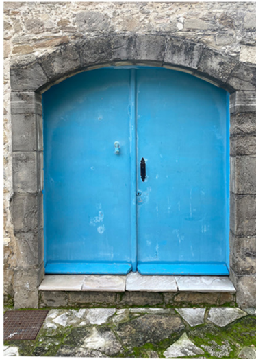
4. Σανιδωτή δίφυλλη τοξωτή εξώθυνα, με περιθύρωμα και κατεργασμένη πέτρα.
