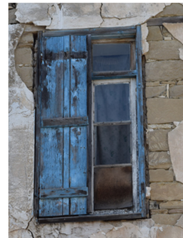
3. Σανιδωτό δίφυλλο παράθυρο με ζυγούς, με οριζόντιο ανώφλι και χρήση γυαλιού.
