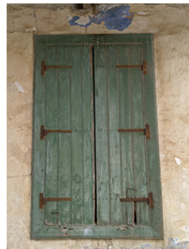
2. Σανιδωτό δίφυλλο παράθυρο με οριζόντιο ανώφλι.
